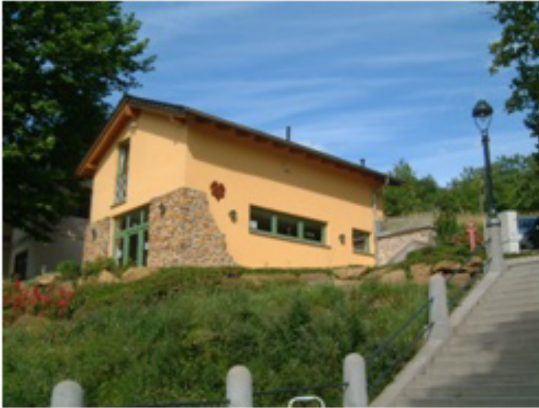
Das Vereinsheim nach der Fertigstellung 2005
