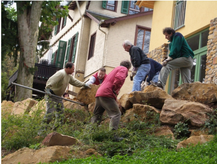
Schwerstarbeit bei den Außenanlagen
