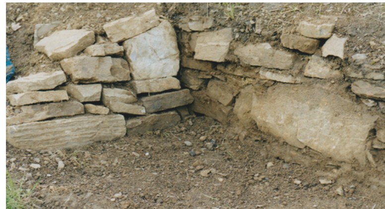
Historische Bruchsteinmauer des Weinbergs aus dem 19. Jh.
